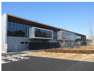
第一厚生棟（小山工場内）
